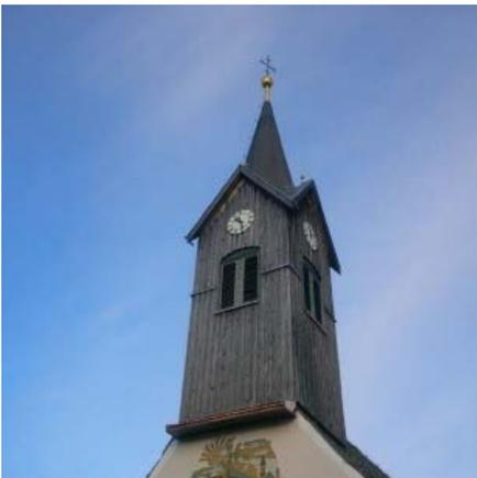
Im letzten Jahr an der Fassade der Pfarrkirche wurden die ersten Schäden behoben: das Vordach wurde neu aufgesetzt, die abgerissene Dachrinne erneuert, kleine Wasserfänger beim Turm angebracht sowie zwei kleine Kupferpyramiden als Mauerschutz angebracht. Im Frühjahr werden die Kirchenfassade, das Gitter beim Kircheneingang und das Friedhofsgitter gerichtet.
